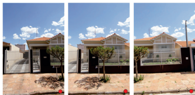
Levantamento fotográfico frontal georreferenciado
